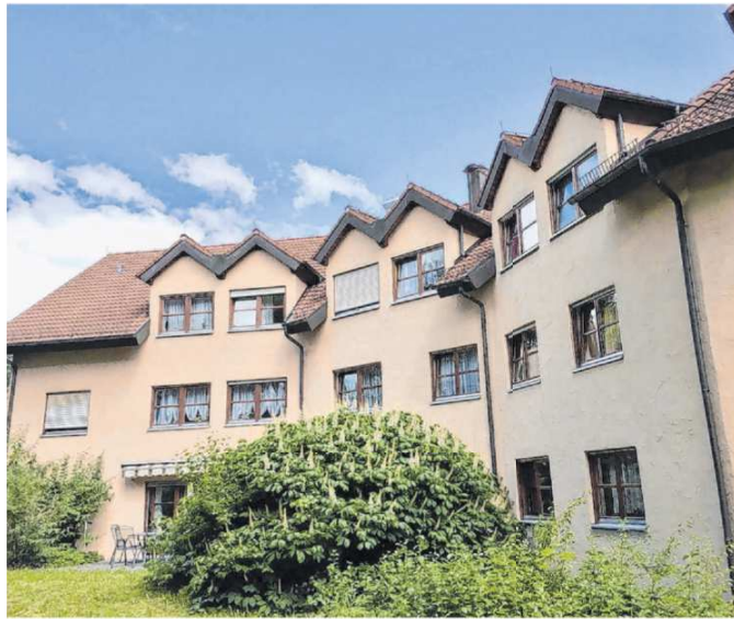
Das Wohnheim am Daimlerplatz in Geislingen: Wegen der neuen Landesheimbauverordnung und wegen schärferer Brandschutzauflagen muss die Lebenshilfe das Haus aufgeben. Foto: Roderich Schmauz
